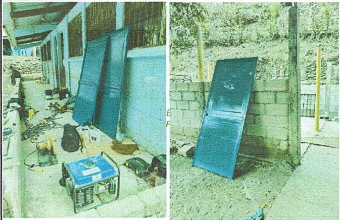
Foto 3: Proceso de mejoramiento e instalación de tres puertas de metal.
